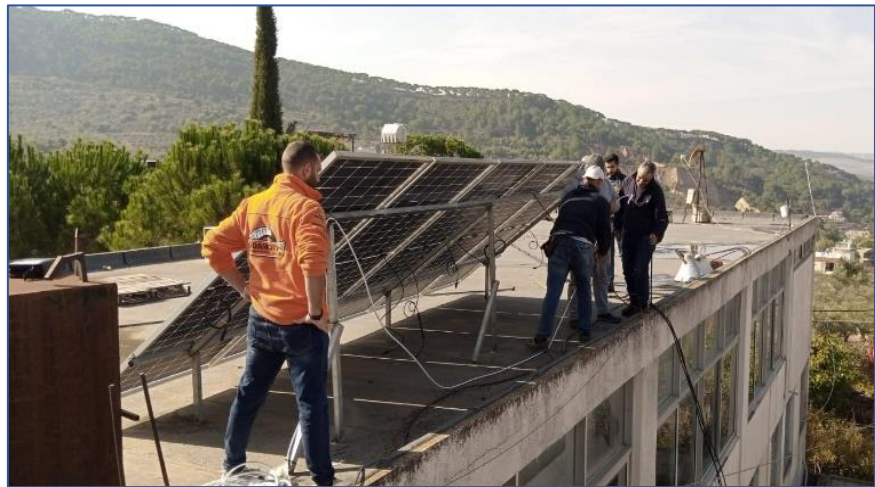
Installation de panneaux solaires sur le bâtiment de la fédération
